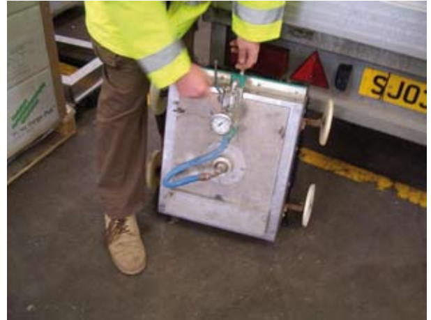
Cabezal de limpieza cerrado para el tratamiento del fibrocemento
